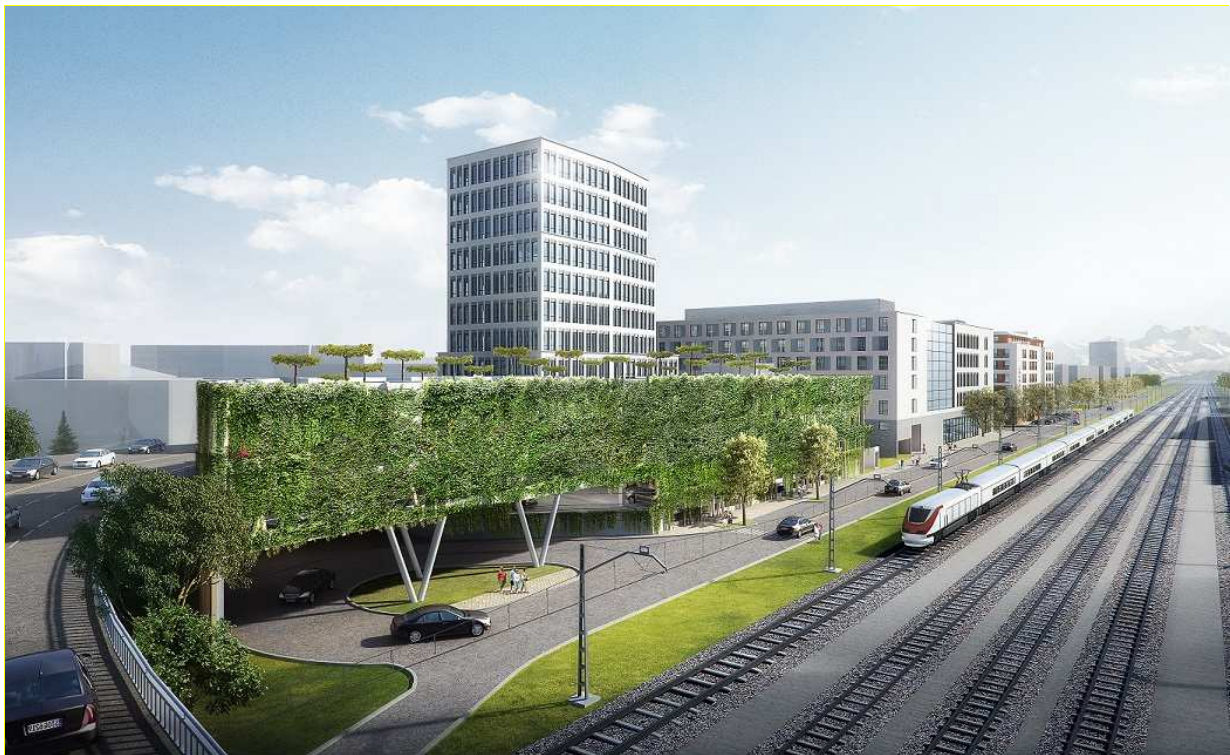
Premier Inn wird ein Hotel in den Rosenheimer Lokhöfen eröffnen. (Visualisierung: ATP Architekten)
